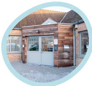
Centre Administratif Comines
