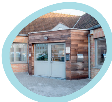
CENTRE ADMINISTRATIF DU CPAS COMINES
