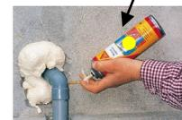
Si le plafond n'est pas libre (canalisations, câbles électriques, poutres,...), enveloppez ou mousez les obstacles au mieux afin d'obtenir une isolation continue, sans pont thermique.
